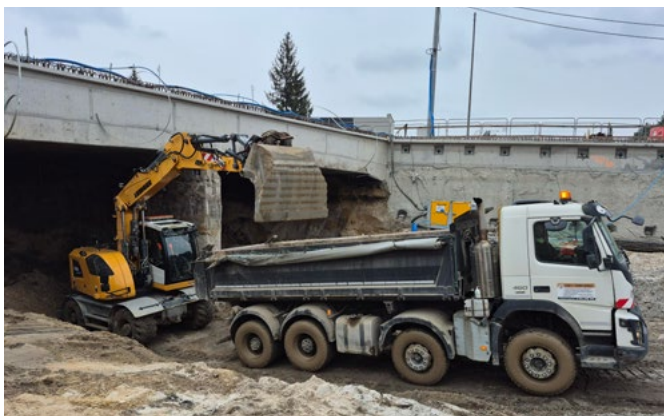
Tunel w Zabierzowie
